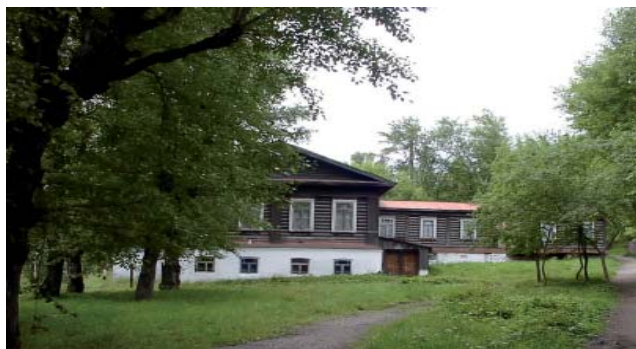
Рис. 2. Здание стационара Покровской районной больницы, 1958 г.
