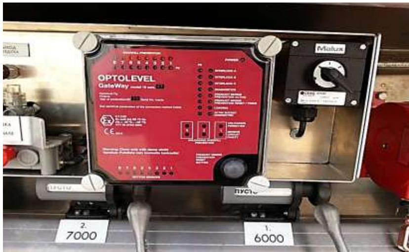
Рисунок 4 - Блок управления датчиков уровнемеров
