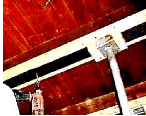
Рисунок 2 – Усиление методом подрацивния деревянной балки
