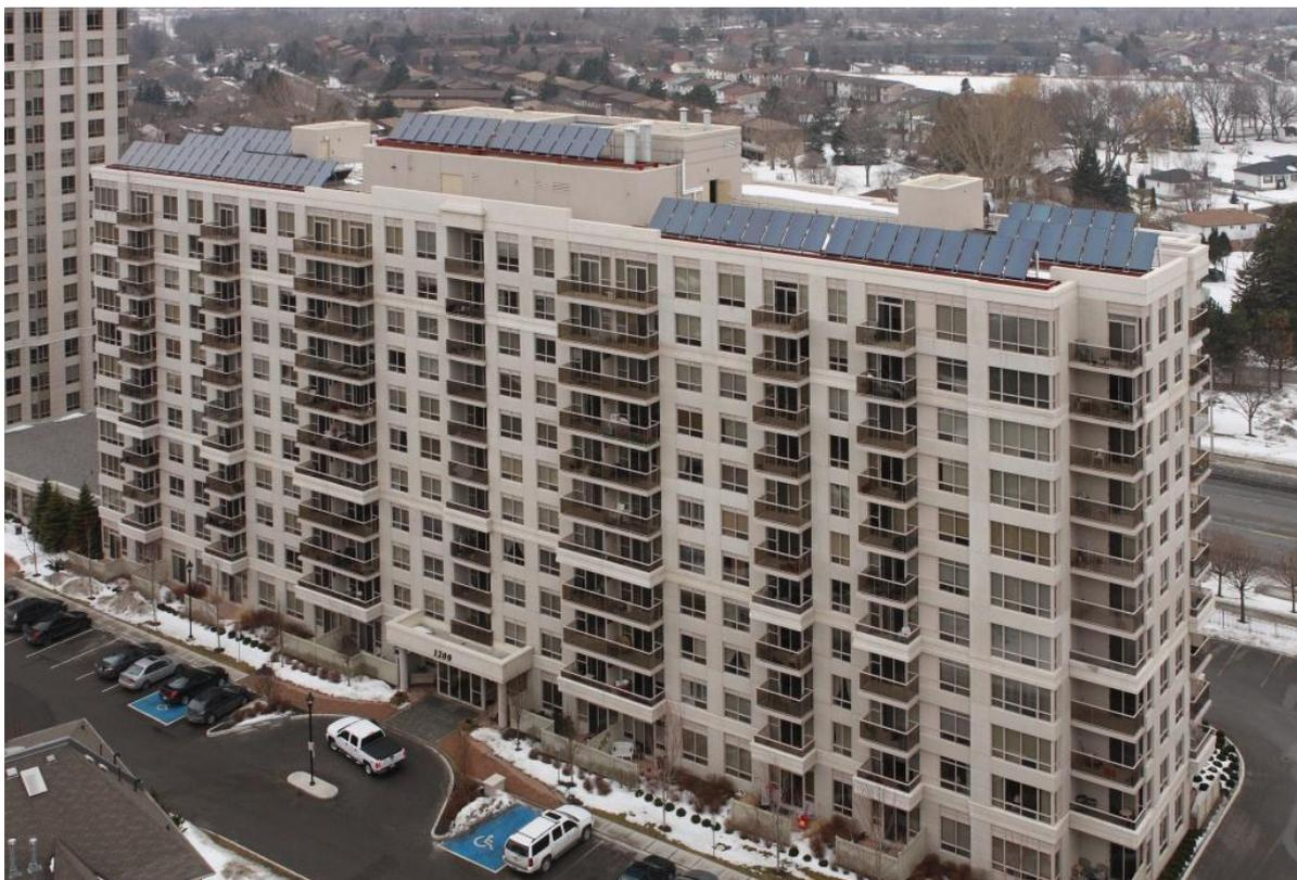
*Рисунок 1 – Пример включения солнечных панелей в объемно-планировочную структуру жилого здания (Москва, ул. Днепропетровская 16-ти этажный жилой дом район Олимпийской деревни)*
