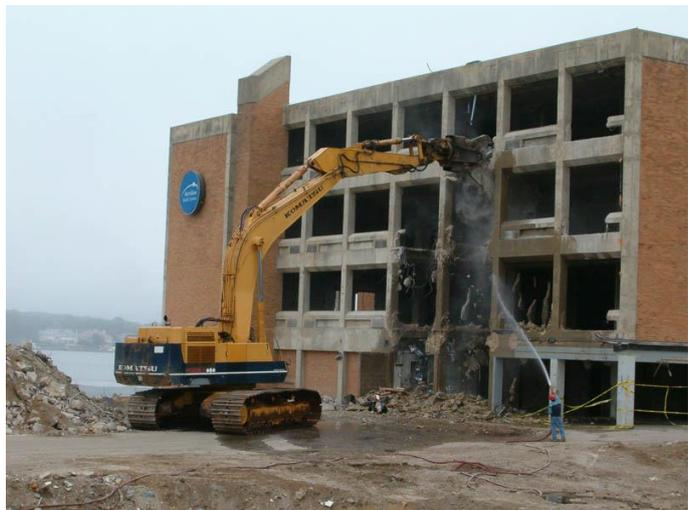
*Рисунок 1 – Демонтаж здания с помощью спецтехники*
