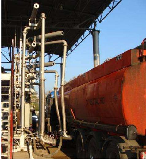
Рисунок 3 – Установка налива в автоцистерну
