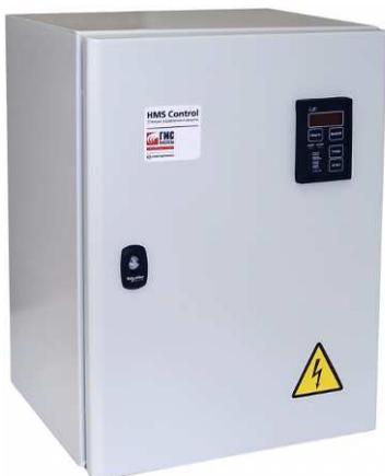
Рисунок 2 – Станция управления и защиты с устройством плавного пуска
