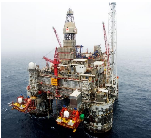
Рисунок 2 – Плавающая платформа «Heidrun» для добычи нефти, установленная на глубине 300 м в норвежском секторе Северного моря. Элементы конструктивного каркаса платформы, а именно цилиндрические оболочки больших диаметров выполнены из легкого бетона класса по прочности на сжатие LC 60 (B60 по ГОСТ 25820)
