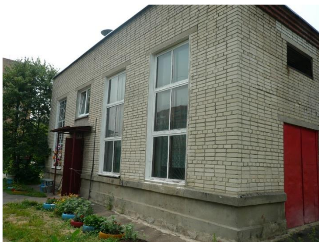
Рисунок 1 – Общий вид надземной части канализационной насосной станции
