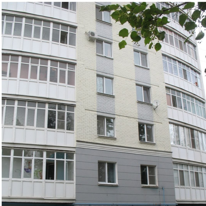
Рисунок 2 – Исследуемый фрагмент фасада жилого дома в городе Орле
