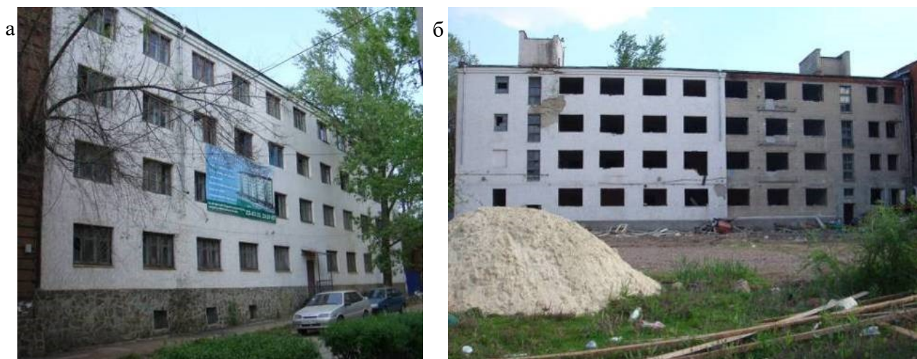
а – общий вид фасада здания в осях 1-7; б – общий вид фасада здания в осях 7-1 Рисунок 4.4 – Общий вид фасадов восстанавливаемого здания в г. Новочеркасске
