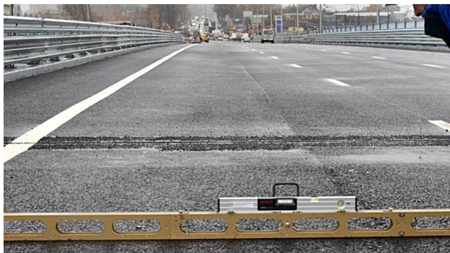
Рисунок 3.4 – Измерение уклона дорожного полотна рейкой с уровнем
