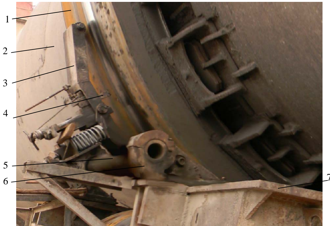
Рис. 4.5. Обработка бандажа вращающейся печи 5x185 м станком УВС-01 с ДСС: 1 – бандаж; 2 – корпус печи; 3 – ДСС; 4 – резец; 5 – направляющая станка; 6 – опорная стойка; 7 – сменные технологические наладки
