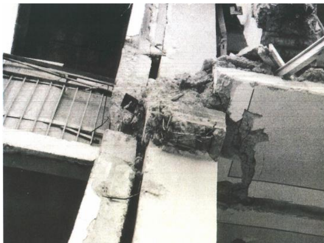
Рисунок 2 – Разрушение узла здания с железобетонным каркасом (Спитакское землетрясение)
