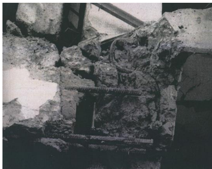
Рисунок 3 – Разрушение узлов здания с железобетонным каркасом рамно-связевой конструктивной схемы. Непроектное выполнение узла (Спитакское землетрясение)
