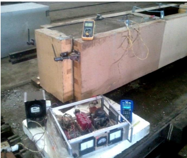
Рисунок 2 - Внешний вид опалубки в процессе ЭТО при изготовлении фундаментных блоков типа ФБС 12.4.6 в начальный момент (слева) и готового изделия после распалубки (справа): на рисунке слева на переднем плане слева направо – счетчик электроэнергии, источник питания повышенной частоты мощностью 4,5 кВт и портативный осциллограф для регистрации напряжения на электродах опалубки
