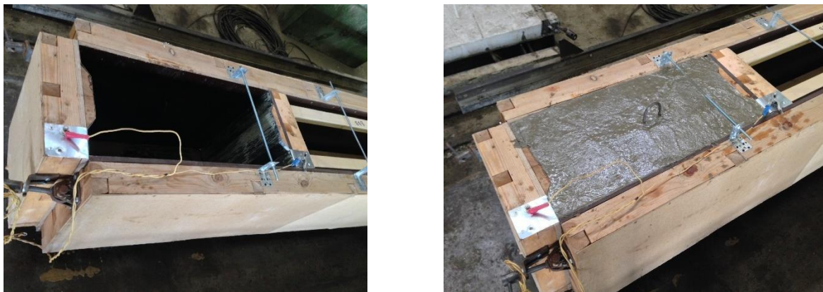
Рисунок 1 - Внешний вид опалубки для изготовления фундаментных блоков до (слева) и после (справа) укладки свежего бетона: электроды установлены на торцевых поверхностях опалубки, т.е. электрический ток протекает вдоль блока
