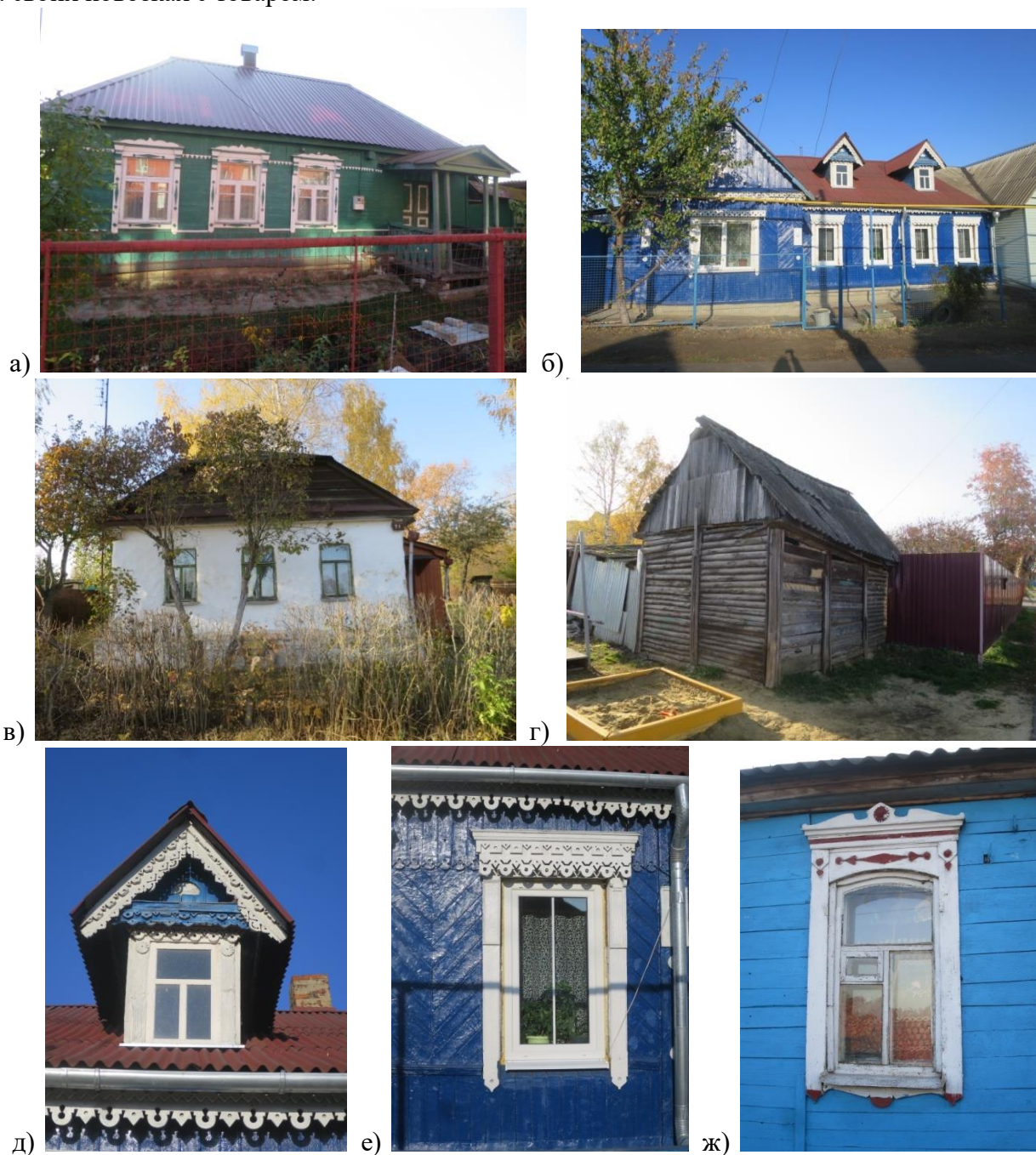
Рисунок 10 - Историческая застройка торгово-жилых кварталов. Деревянные жилые и хозяйственные постройки в быв. м. Коренная пустынь (п. Свобода), фото автора, 2020 г.: а-г) типы жилых и хозяйственных построек, д-ж) декоративная отделка фасадов.
