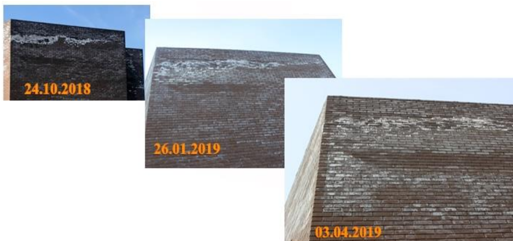
Фото 4 - Мониторинг за высолами на поверхности облицовочного кирпича здания лаборатории
