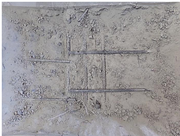
Рисунок 3 - Стык верхней продольной рабочей арматуры плиты перекрытия над средней балкой
