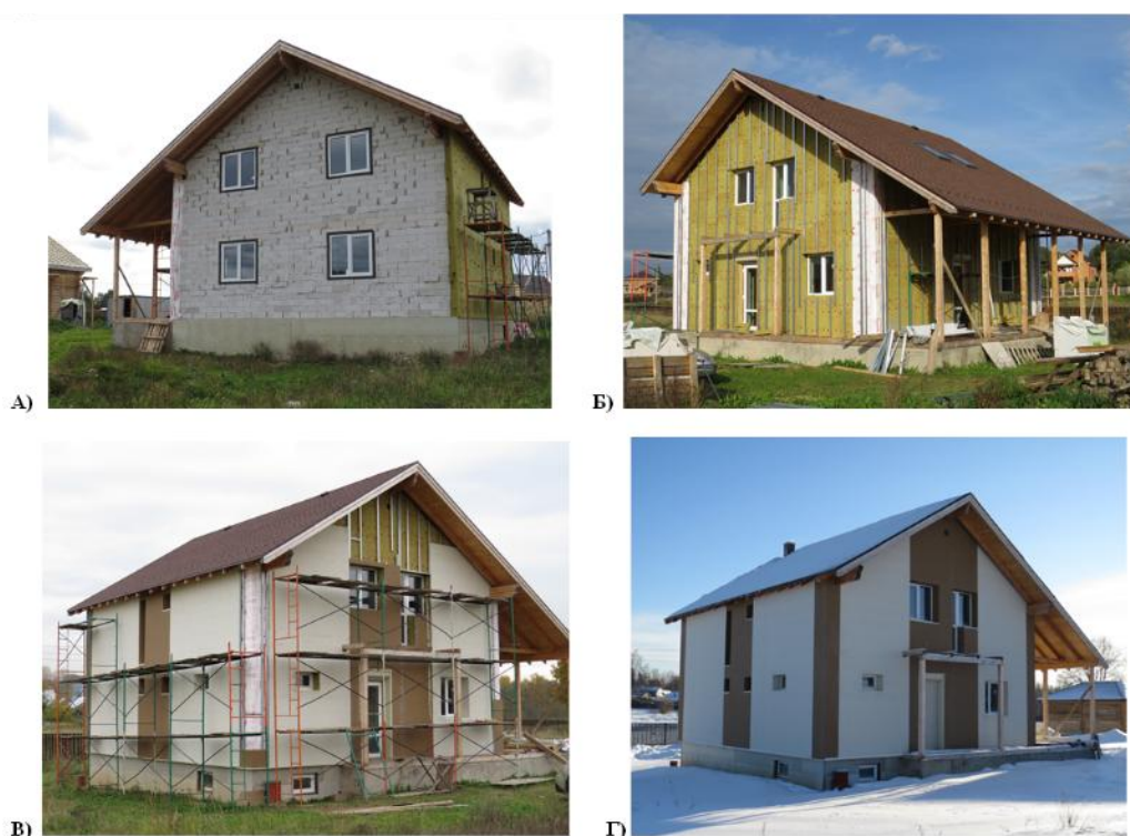
Рисунок 3 - Этапы строительства фасада энергоэффективного дома
