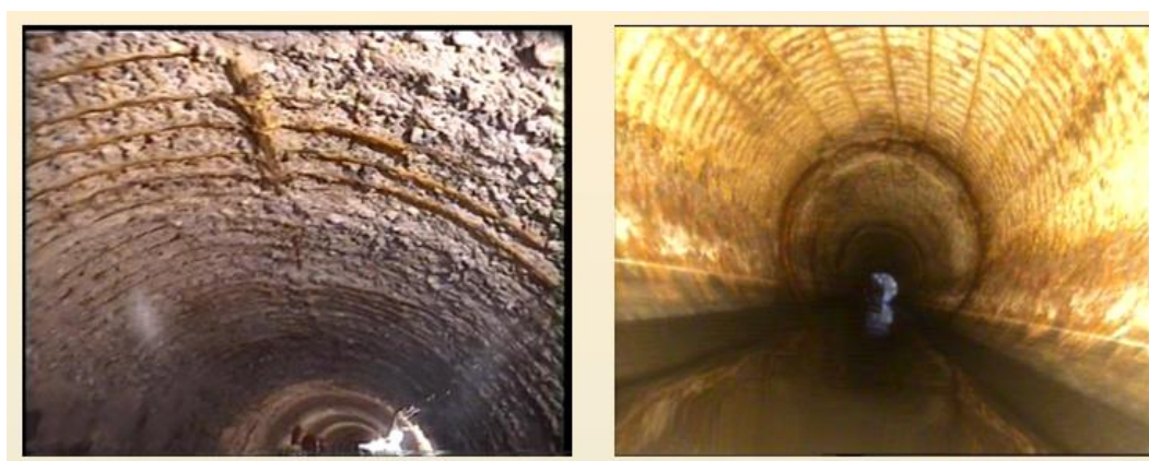
Рисунок 1 - Газовая коррозия железобетонного трубопровода
