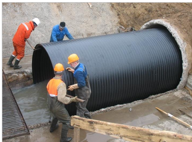
Рисунок 7 - Реконструкция канализационного коллектора
