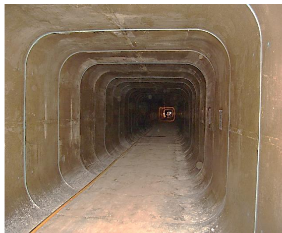
Рисунок 3 - Подводящий канал к ЛОС после реконструкции
