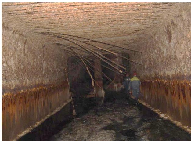
Рисунок 2 - Техническое состояние подводящего канала к ЛОС до реконструкции
