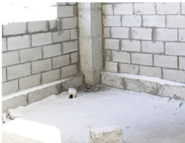
Рисунок 6 - Использование конструктивных решений примыкания наружных (а) и внутренних (б) ограждающих конструкций к цокольному перекрытию при проектировании и строительстве многоэтажного жилого здания в одном из микрорайонов г.Якутска
