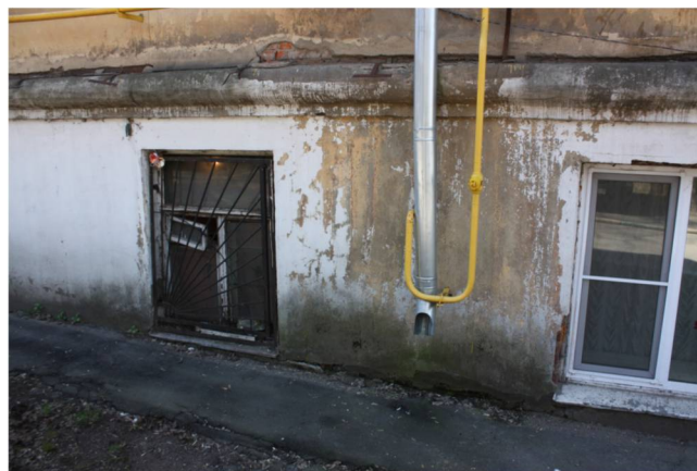
Рисунок 3 – Разрушение штукатурного и окрасочного слоя цоколя, наружных стен
