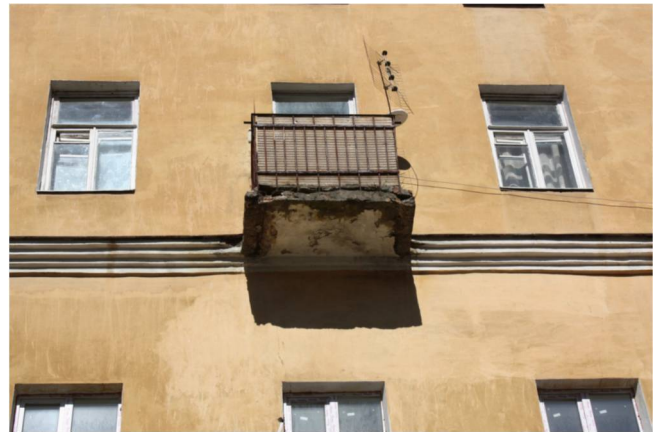
Рисунок 2 – Разрушение защитного слоя бетона балконных плит. Коррозия арматуры
