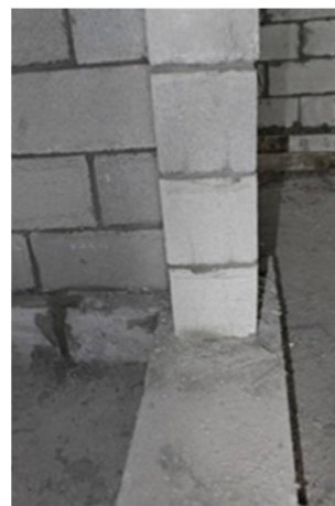
Рисунок 6 - Использование конструктивных решений примыкания наружных (а) и внутренних (б) ограждающих конструкций к цокольному перекрытию при проектировании и строительстве многоэтажного жилого здания в одном из микрорайонов г.Якутска
