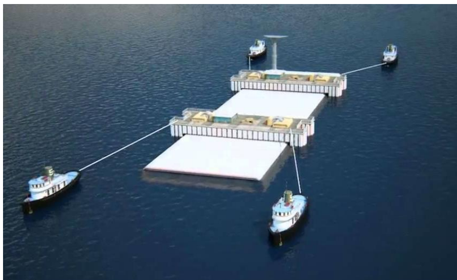
Рисунок 1 - Транспортировка тоннельной секции
