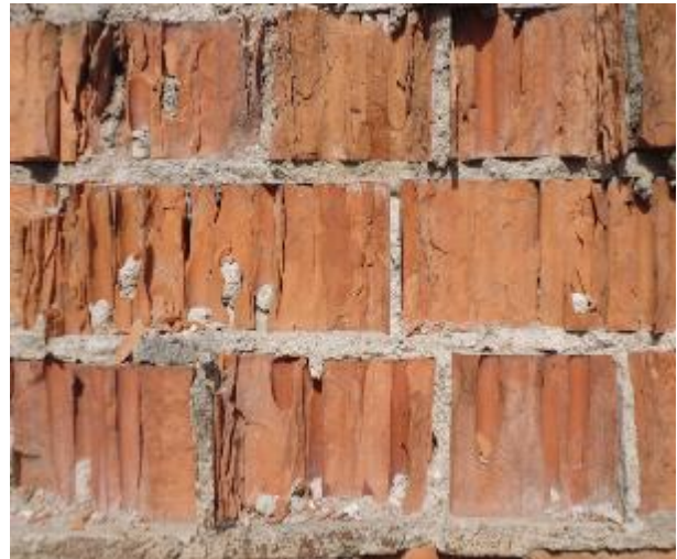
Рисунок 1 – Разрушенная кладка из пустотелого кирпича (кладка выполнена в 90-е годы XX века)
