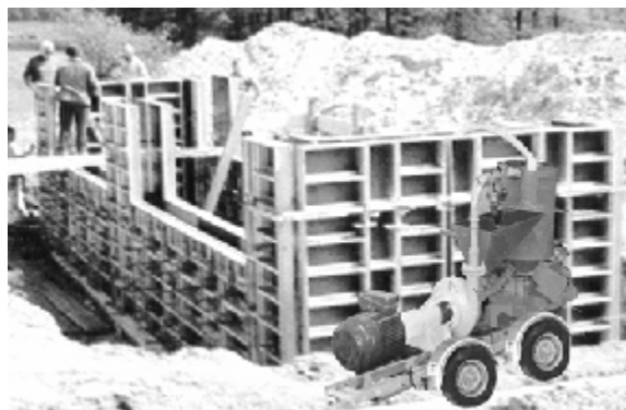
Рисунок 1 – Использование мобильных установок для приготовления активированных вяжущих композиций при возведении ограждающих конструкций строительных объектов: а) с применением стеновой щитовой опалубки; б) то же, общий вид объекта строительства
