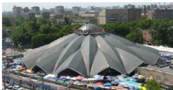
Рисунок 12 – Здание Даниловского рынка с покрытием в виде железобетонного складчатого купола со встречными складками-козырьками; D = 72 м (архитектор покрытия - Нодар Канчели);
