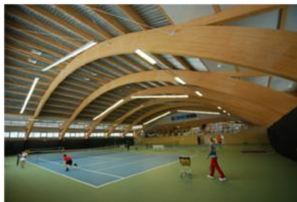
Рисунок 9 – Интерьер «Теннисного центра» с 2-шарнирными арками пролетом 42м. (Источник: фото С.Б.Турковского)
