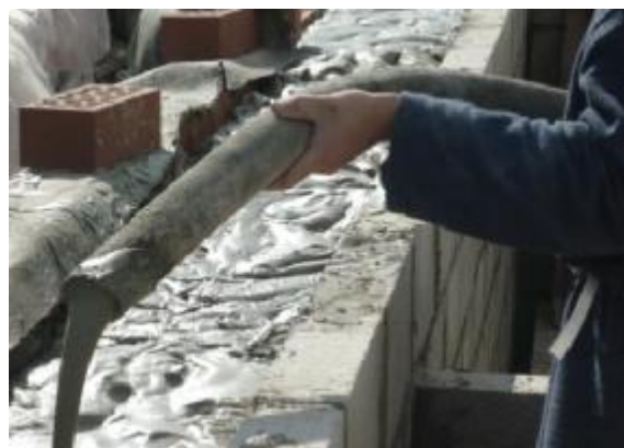
Рисунок 2 – Нанесение бетона низкой плотности: а) на поверхность стены (опалубки); б) подача внутрь кирпичной стены с помощью гибкого шланга
