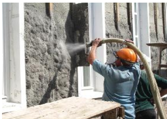
Рисунок 2 – Нанесение бетона низкой плотности: а) на поверхность стены (опалубки); б) подача внутрь кирпичной стены с помощью гибкого шланга
