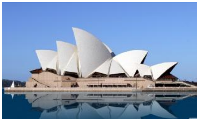
Рисунок 14 – Складчатое покрытие оперного театра в Сиднее, Австралия
