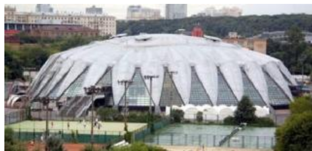
Рисунок 13 – Здание УСЗ "Дружба" Олимпийский комплекс "Лужники" со складчатым железобетонным покрытием (наибольший пролет оболочки в плане - 96 м; макс. высота конструкции зала - 20 м)
