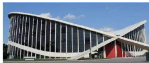
Рисунок 18 – Седловидное висячее покрытие арены в городе Ралей, США (Источник: [3])
