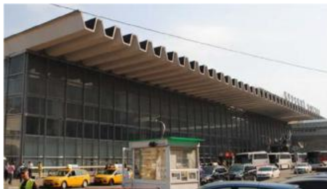
Рисунок 15 – Здание Курского вокзала с железобетонным складчатым покрытием длиной 45 м
