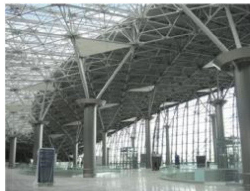
Рисунок 19 – Строительство сетчатой конструкции покрытия аэропорта Внуково
