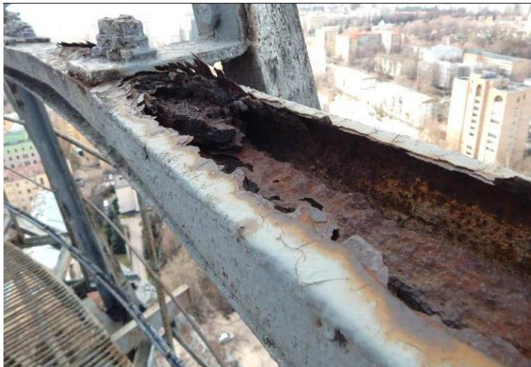
Рисунок 2 – Сквозная коррозия в промежуточных спаренных кольцах секции 4
