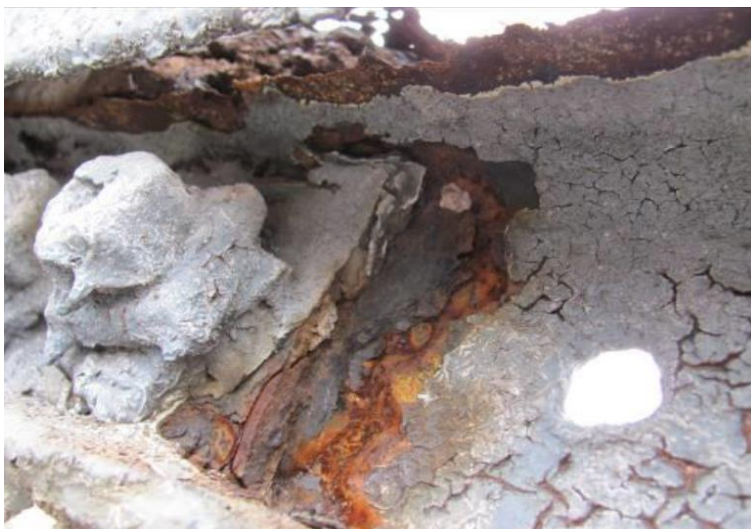
Рисунок 3 – Глубокая язвенная коррозия отмечена на границах соединений элементов
