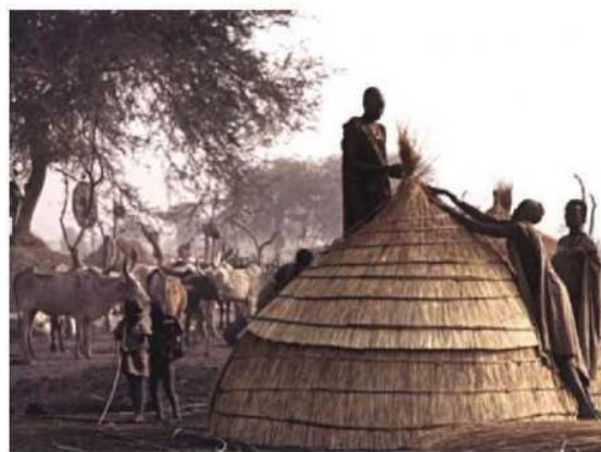
Рисунок 2 - Восточно-африканское кочевое убежище из палочной рамы, покрытой люком.
