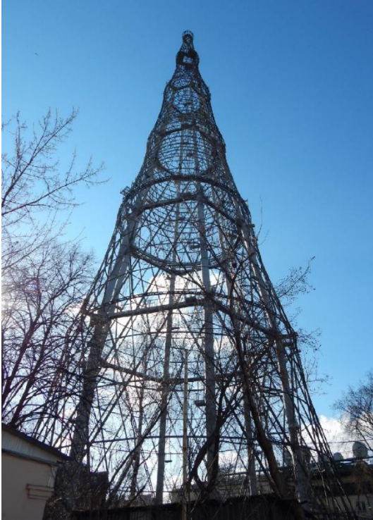
Рисунок 1 – Общий вид Радиобашни с опорной конструкцией внутри
