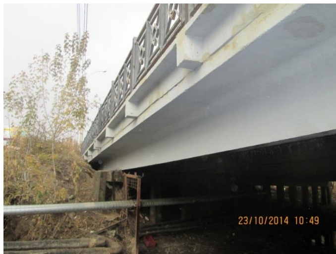
Рисунок 3 - Балка пролетного строения после ремонта (мост через р. Липовка по ул. Неделина в г. Липецке)
