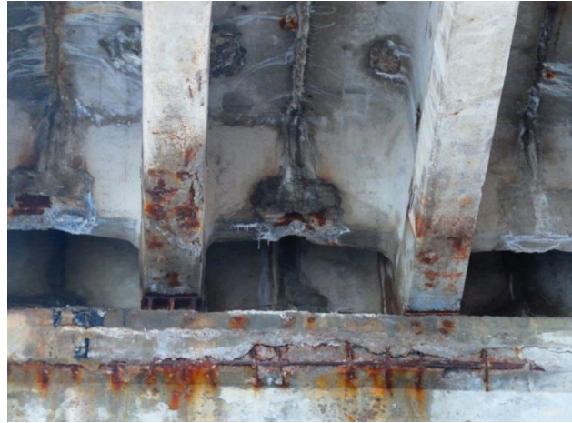
Рисунок 2 - Замокание и разрушение бетона, оголение и коррозия арматуры в главных балках и ригеле моста через реку Сосна в г. Ельце Липецкой области
