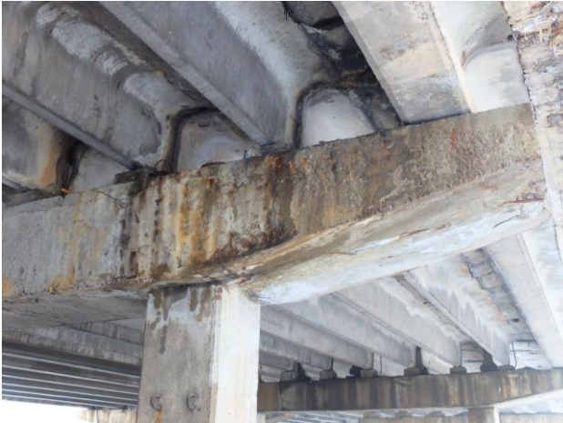
Рисунок 1 - Замокание ригеля под балками, разрушение защитного слоя бетона, обнажение и коррозия арматуры в путепроводе по ул. Фрунзе в г. Курск
