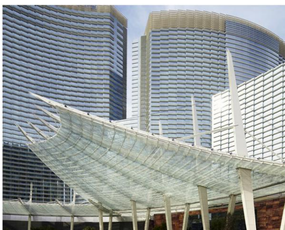
Рисунок 1 – Солнцезащитное устройство гостиницы, Лас Вегас
