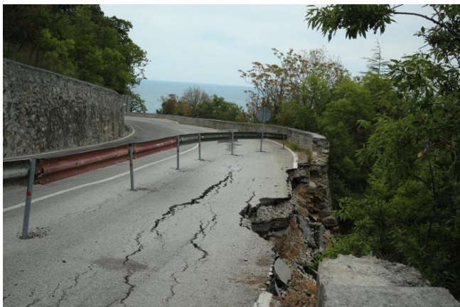
Рисунок 3 – Сквозной вывал в подпорной стене Алушкинского шоссе
