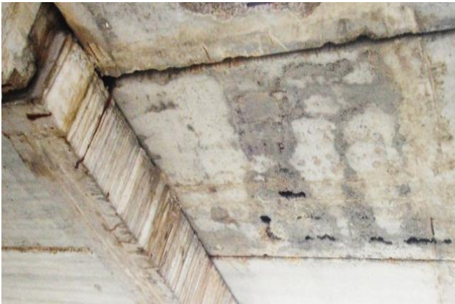
Рисунок 1 - Фрагмент коррозионно-поврежденной плиты
