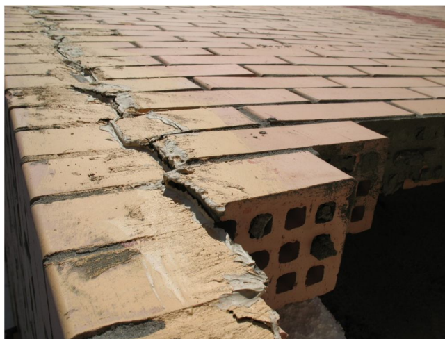
Рисунок 4 – Вертикальные трещины в угловых зонах кирпичной кладки облицовочного слоя
