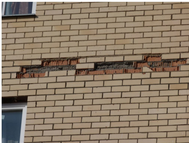
Рисунок 5 – Отслоение лещадок кирпичей кладки облицовочного слоя вследствие отсутствия горизонтальных деформационных швов
