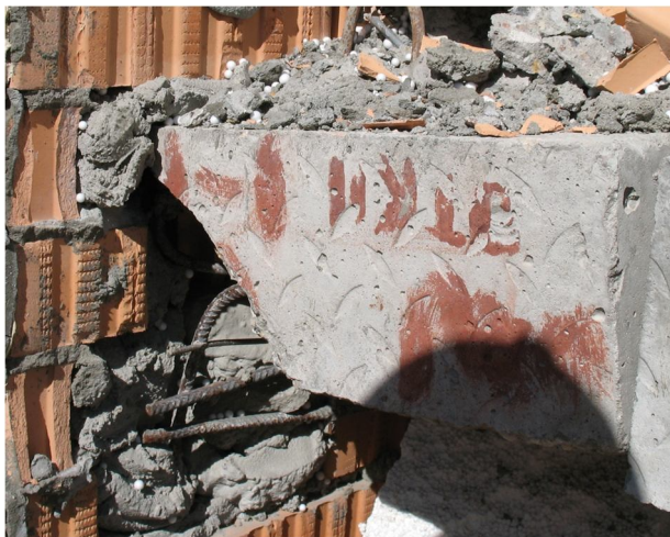
Рисунок 3 – повреждение сборных железобетонных элементов опорных балок
