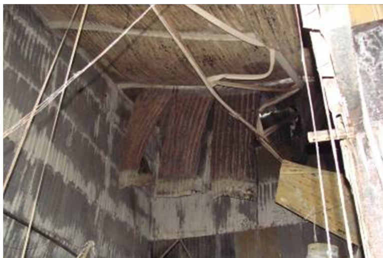
Рисунок 2 – Состояние конструкций покрытия после пожара
