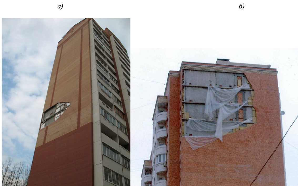
Рисунок 1 – Общие виды стен жилых домов после обрушения участка облицовочного слоя
