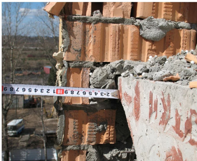
Рисунок 6 – Недостаточное опирание кирпичной кладки облицовочного слоя на опорные балки
