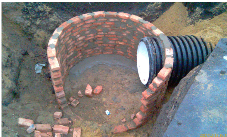
Рисунок 2 – Переходной колодец строящегося коллектора
