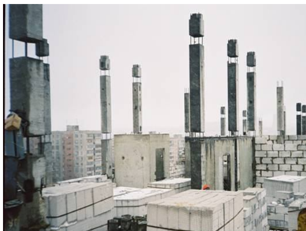
Рисунок 1 – Общий вид (а) и узел сопряжения ригелей (б) сборно-монолитного каркаса
