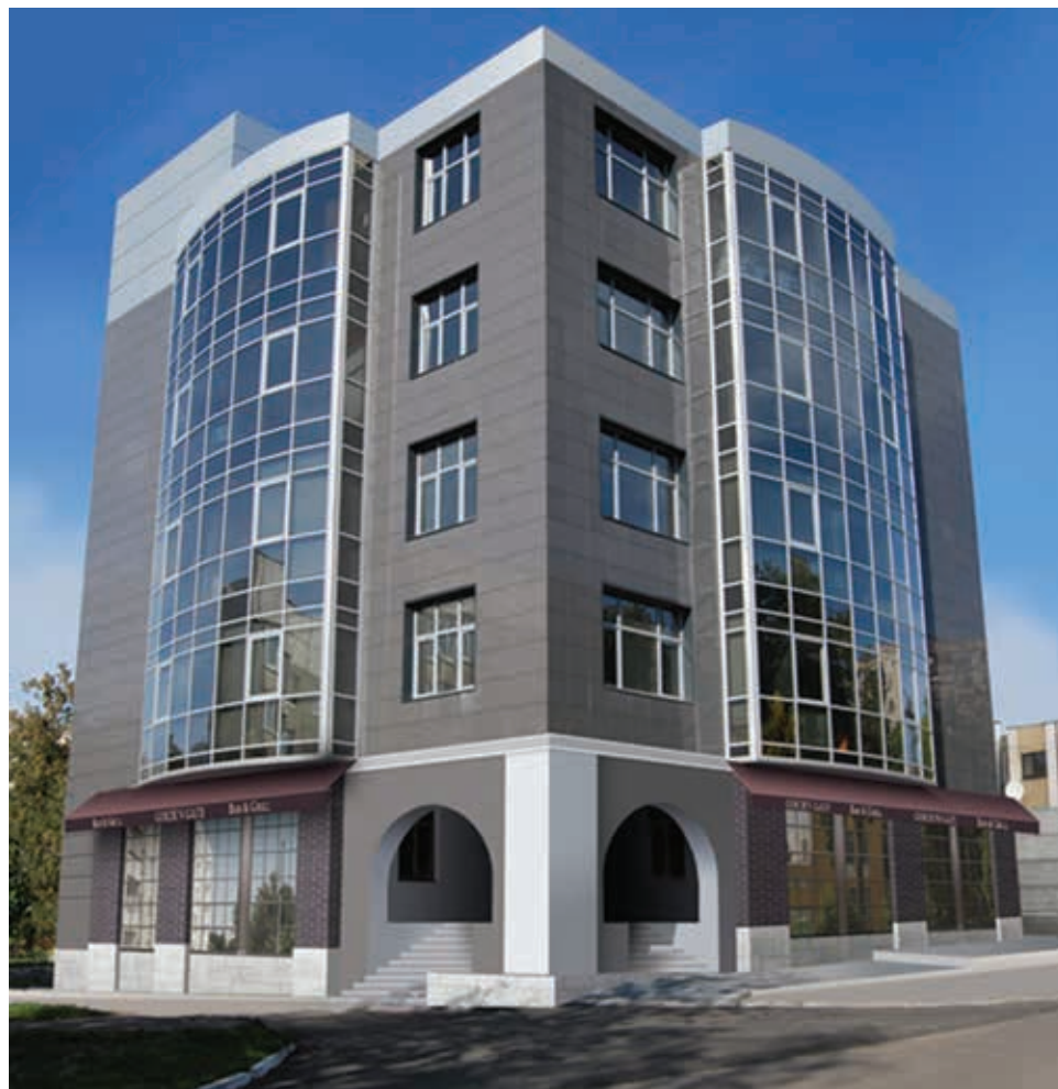
Inventos Tower – новый дом компании «Инвентос» на улице Русанова
